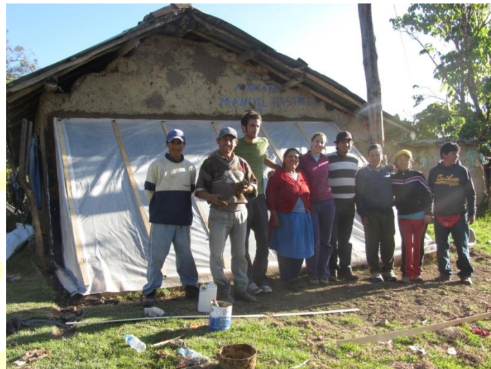
Finalización del muro trombe
