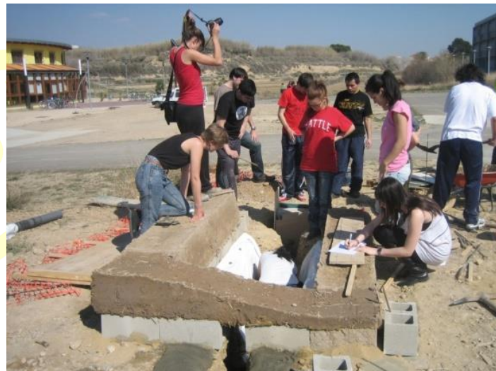
Alumnado realizando zanja para biodigestor
