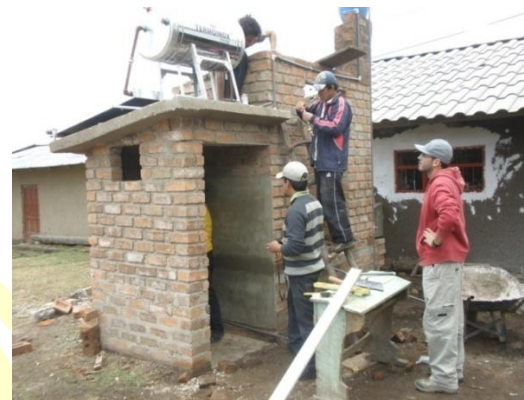
Montaje de los saneamientos ecológicos
