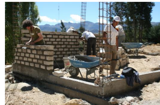
Construcción de camal de cuyo
