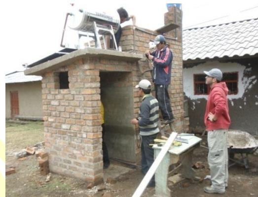
Montaje de los saneamientos ecológicos
