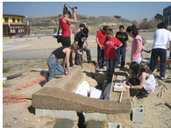
Alumnado realizando zanja para biodigestor
