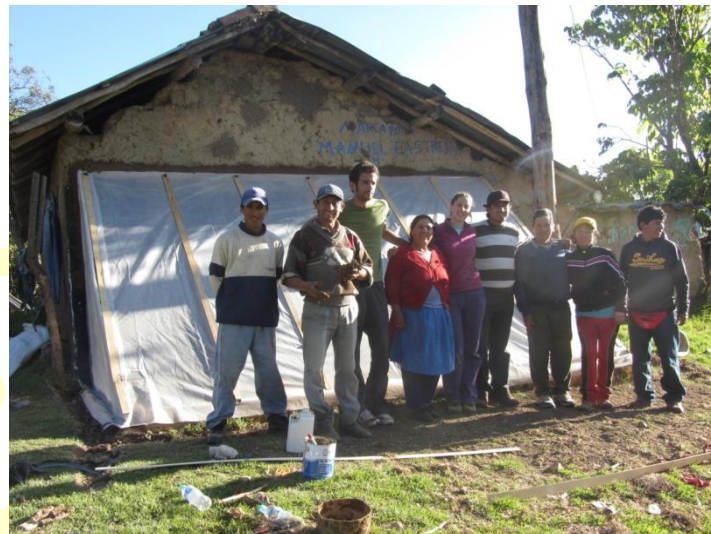
Finalización del muro trombe
